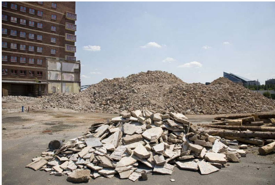
Obrázok 61 Ručné odstraňovanie muriva a demolácia západnej prístavby
