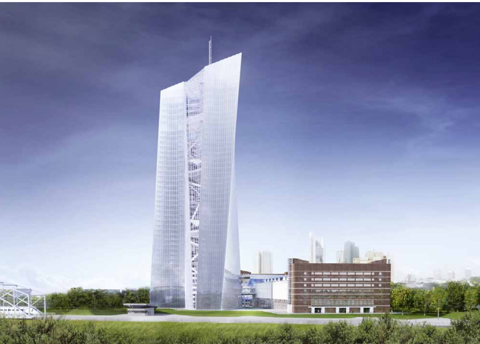
Новата сграда на ЕЦБ – изглед от изток. Новата сграда на ЕЦБ, която се изгражда по проект на COOP HIMMELB(L)AU , трябва да бъде завършена до края на 2013 г. Комплексът се състои от три основни архитектурни елемента: двукорпусната административна сграда, Гросмарктхале и порталния блок.
